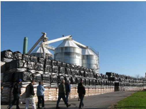
Figure 6. Usine de granulé de bois de la Nouvelle-Angleterre à Schuyler, N.Y.
